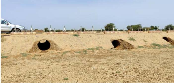
**Figure 49 : Route en remblai avec buses**
