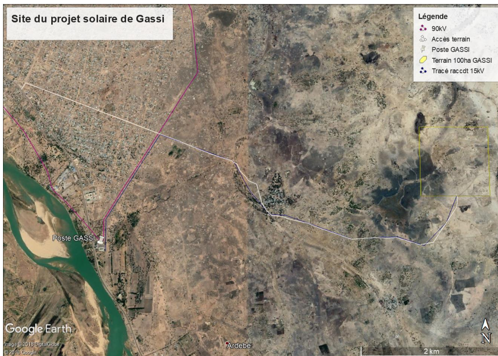
Figure b : Centrale Gassi et son raccordement
